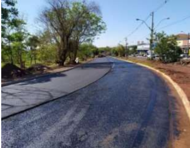
Figura 18 – Aplicação de binder
