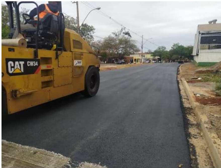
Figura 20 – Aplicação da segunda camada de CBUQ
