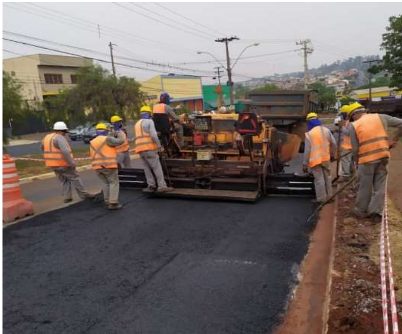
Figura 19 – Execução da primeira cada de CBUQ
