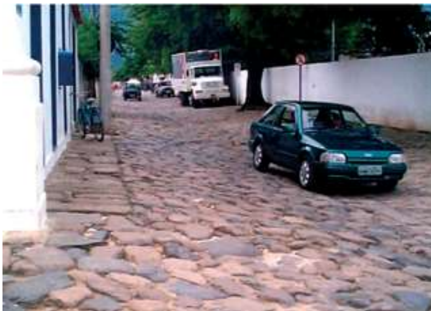
Figura 5 – Pavimentação urbana em Paraty, RJ
