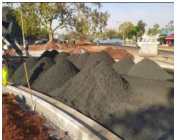
Figura 17 – Recebimento para a camada de BGTC
